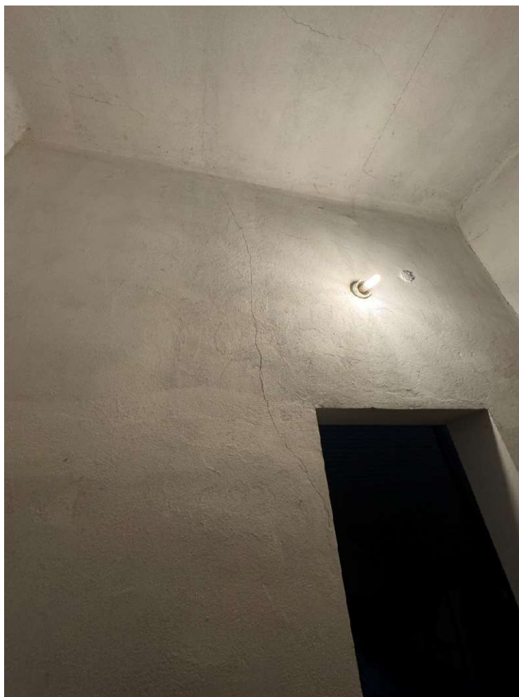
Fot. 7. Widoczne pęknięcie ściany w pom. gospodarczym, źródło: fotografie własne
